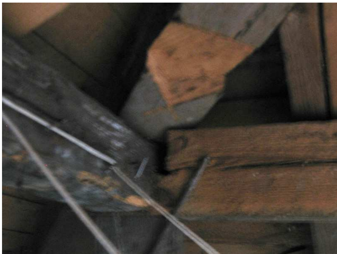
Oslabená nárožní krokev a oslabení vaznice v uložení
